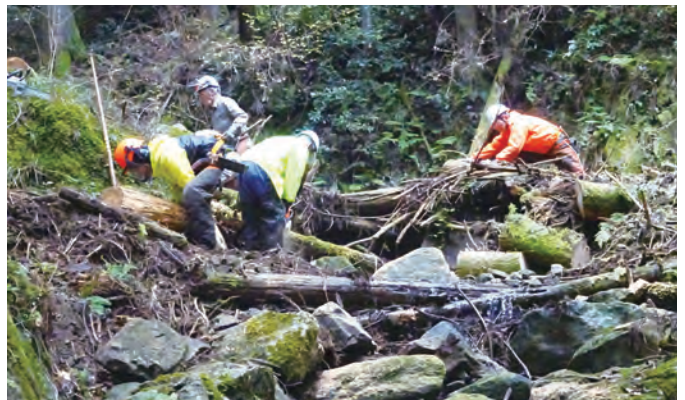
▲ 谷に倒れた枯損木をきれいに片づけるのも大切な作業です。
